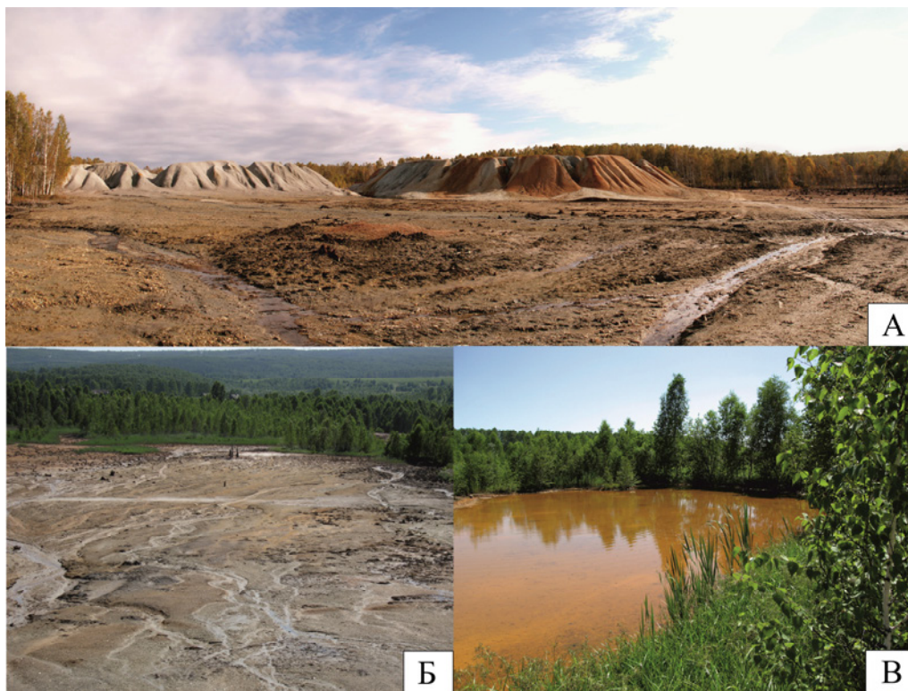
Рис. 2. Фотографии Урского хвостохранилища: А – общий вид (слева отвал отходов первичных руд, справа отвал отходов руд зоны окисления), Б – поток рассеяния, В – техногенный пруд.
