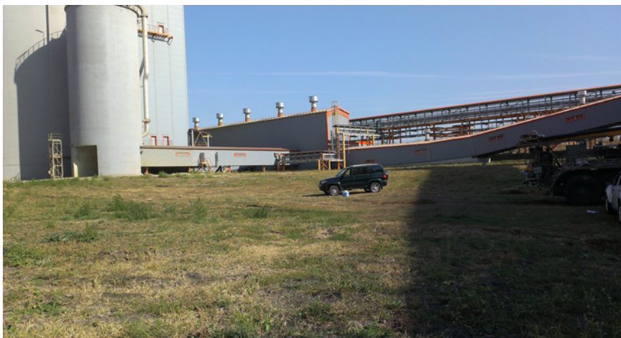
Рис. 2. Участок проектируемой газопоршневой теплоэлектростанции.
