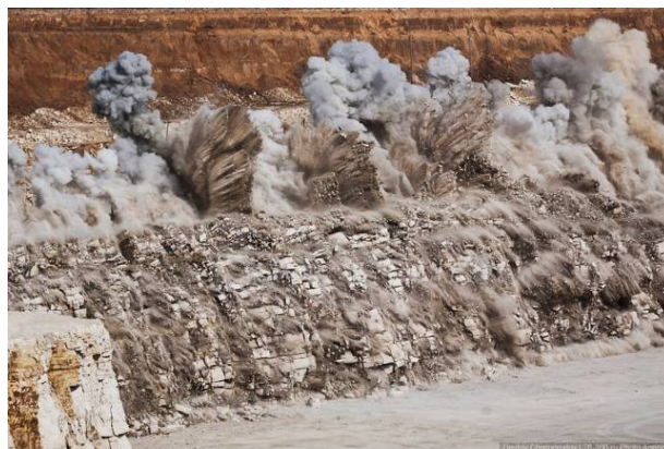
Рис. 1. Буровзрывные работы, проводимые на Ситовском карьере Сокольско-Ситовского месторождения известняков (г. Липецк).
