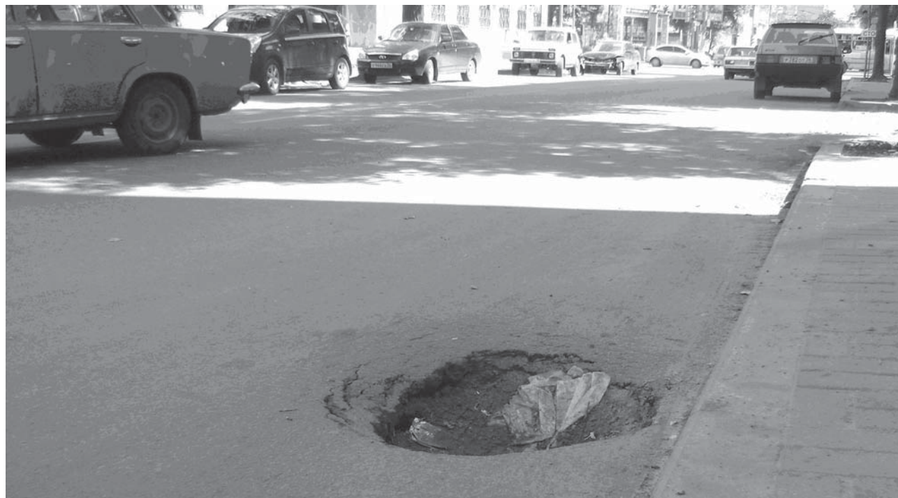
Рис. 5. Провал у дома на ул. Среднемосковская
