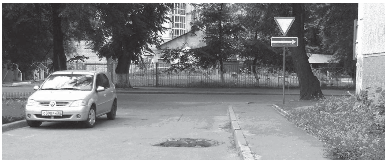
Рис. 3. Провал у выезда на ул. Революции 1905 г.
