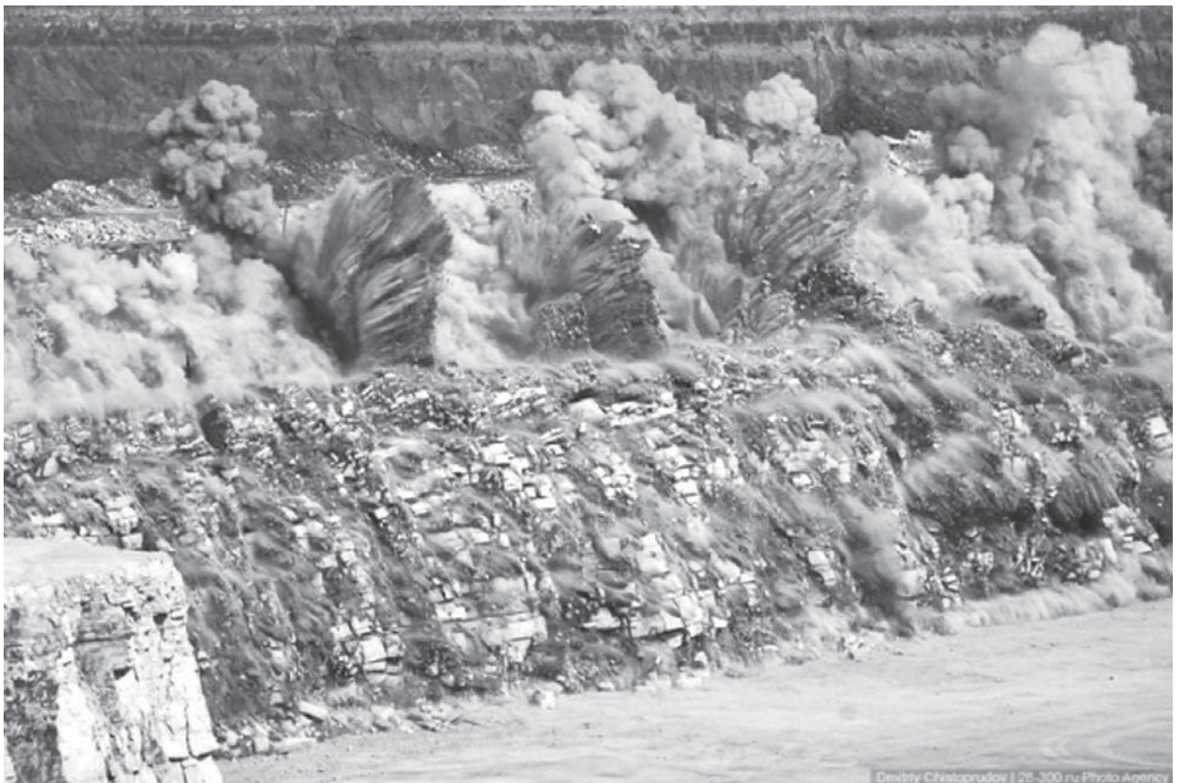
Рис. 1. Буровзрывные работы, проводимые на Ситовском карьере
