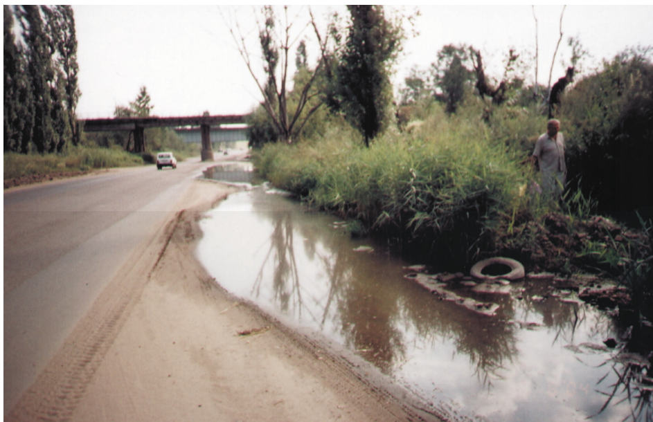
Рис. 3. Заболоченный участок автомобильной дороги на левобережье р. Песчанки в районе ОАО «Воронежсинтезкаучук»
