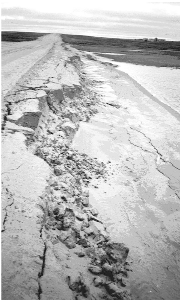
Рис. 1. Автодорога «Промбаза ГП-1 — ГП-2». Абразионное разрушение насыпи на участке постоянного подтопления в пределах хасырея и формирование выположенного откоса.
