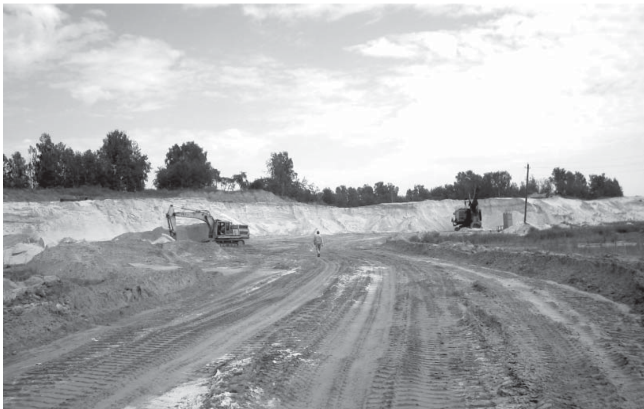
Рис. 22. Фотография борта карьера Чулковского месторождения
