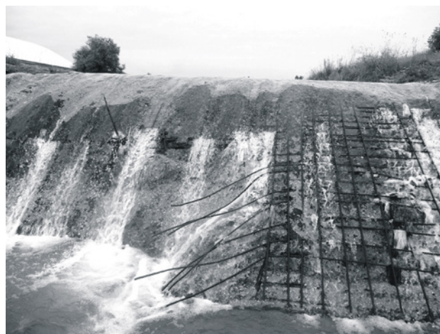
Рис. 1. Абразивная поверхность водослива. Фото автора
